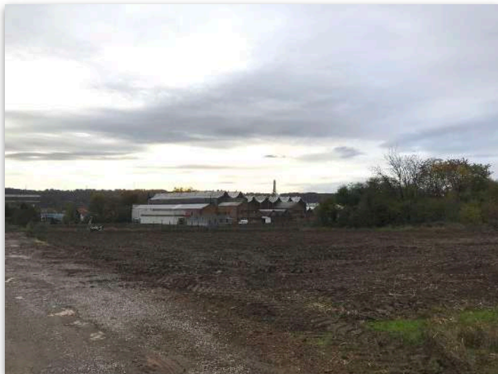
Photo de la rue du Champs des Epreuves à Herstal, exprime un caractère rural résiduel des paysages anciens. ©Alexandre Houthoofdt
