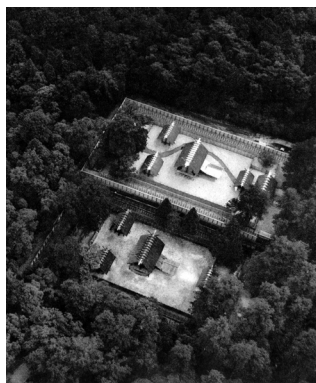
Fig. 66 - Construction du nouveau sanctuaire naikū à côté de l'ancien (1953)
