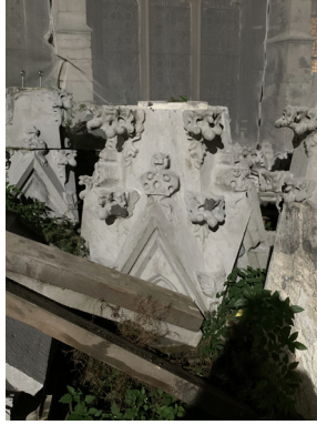
Fig. 50 - Ancienne / Nouvelle base d'un pinacle, 2019
