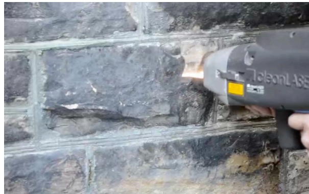
Fig. 58 - Nettoyage au laser de la pierre d'une des façades du Parlement
