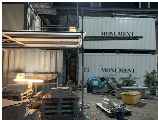
Fig. 54 - Atelier de taille de pierres sur le chantier de la cathédrale, cour du cloître, 2019
