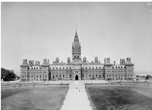
Fig. 56 - Édifice du Centre d'origine, Parlement, environ 1914
