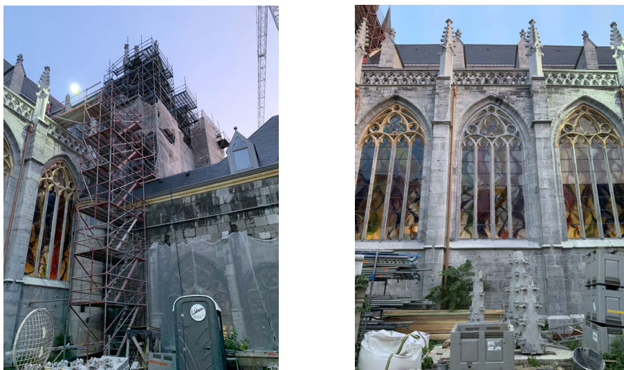
Fig. 38 - Façade sud et galerie du cloître de la cathédrale, restauration en 2019
