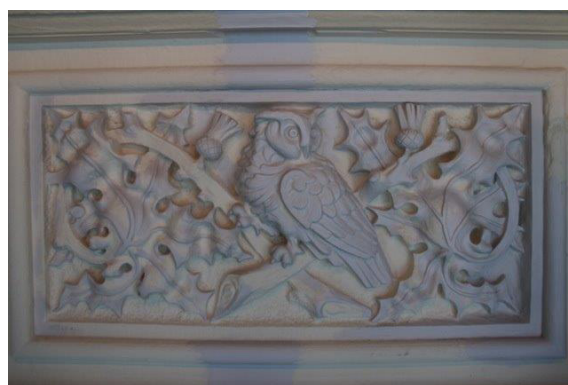
Fig. 62 - Ajout de l'argile pour combler les zones manquantes de la sculpture du hibou de l'aile Est du Parlement, 2014
