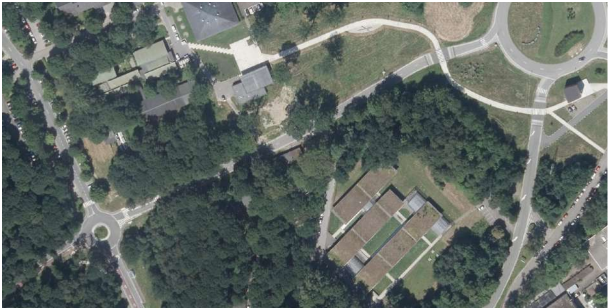
FIGURE 25: La situation en 2018. En plus de la création d'un nouveau petit rond-point, on remarque que la nouvelle liaison est terminée. On trouve le long de celle-ci le pavillon d'accueil au niveau du grand rond-point, et la nouvelle cafétéria «Polytech», dont la création, combinée à celle de la liaison, a nécessité l'abattage d'un certain nombre d'arbres, ensuite replantés de manière maîtrisée.
