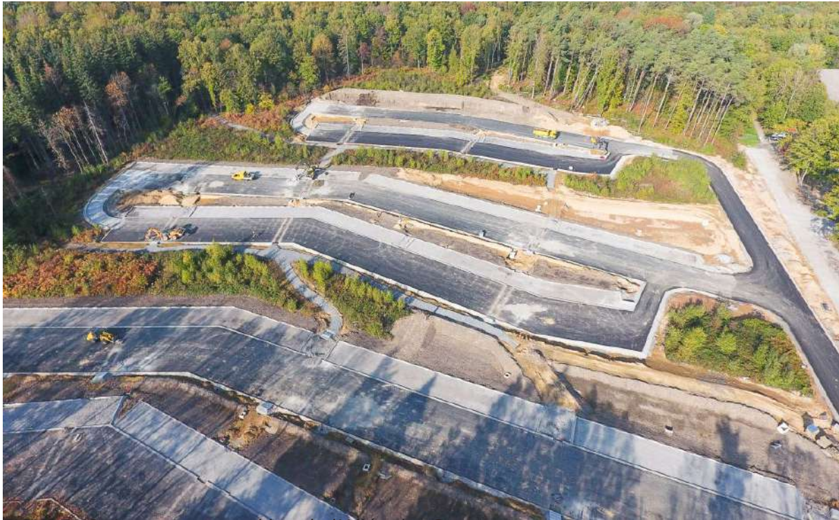
FIGURE 42: Le nouveau parking de l'Allée des Sports, en travaux.
