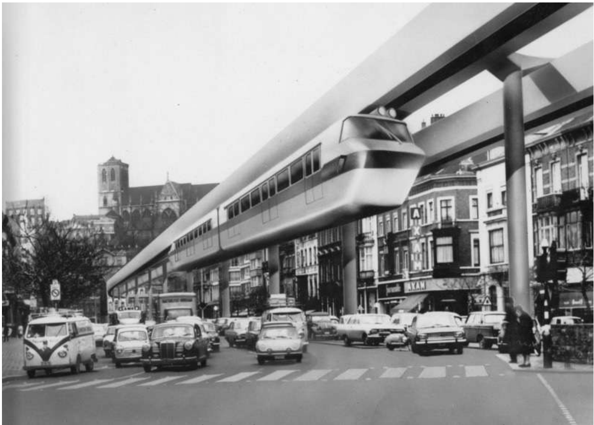
FIGURE 11 : Simulation du Safège à Liège, ici sur le boulevard de la Sauvenière. Parmi les avantages d'un tel système, on peut notamment citer l'absence de travaux importants nécessaires à sa mise en place et le fait que, étant suspendu, les irrégularités du sol n'ont pas d'effet sur lui.
