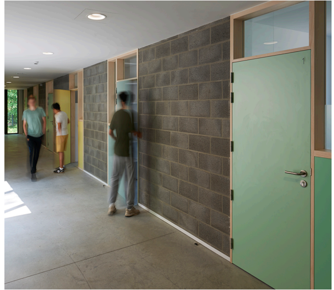
Figure 51 : Visuel des portes depuis le couloir
