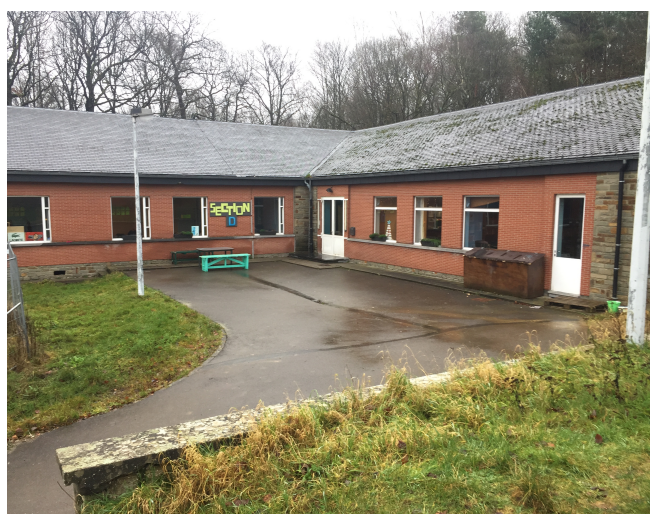
Figure 10: Façades avant de la section D
