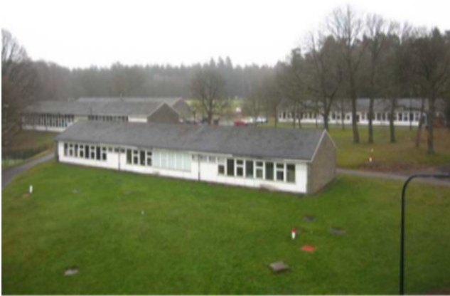
Figure 15 : Vue plongeante sur les RTG des classes et ateliers
