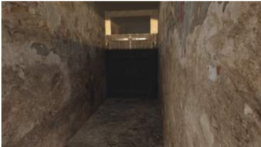
FIGURE 8.24 – Vue depuis le milieu de la salle longitudinale
