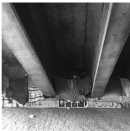
ENTRE SOL ET PLAFOND ENTRE DEUX POUTRES
