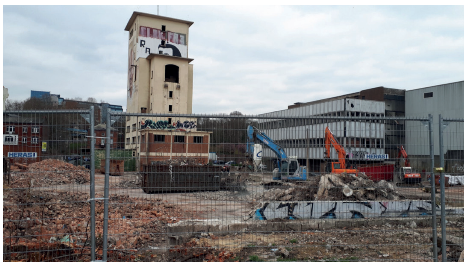
figure 27 : démolition des squats à Interbéton
