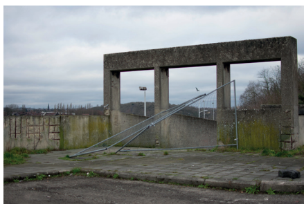
figure 56 : grilles dans les rampes
