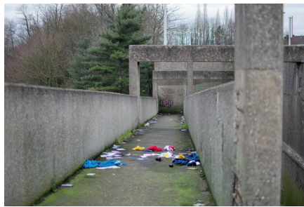
figure 42 : discrétion dans la rampe du PBA
