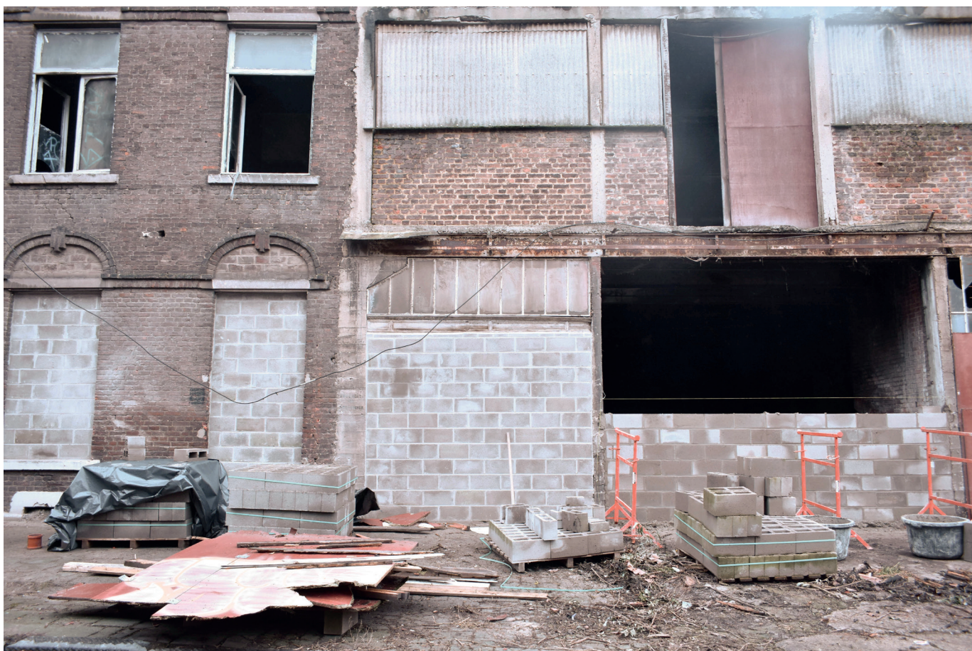
figure 68 : squat 'muré' avant démolition à Interbéton
