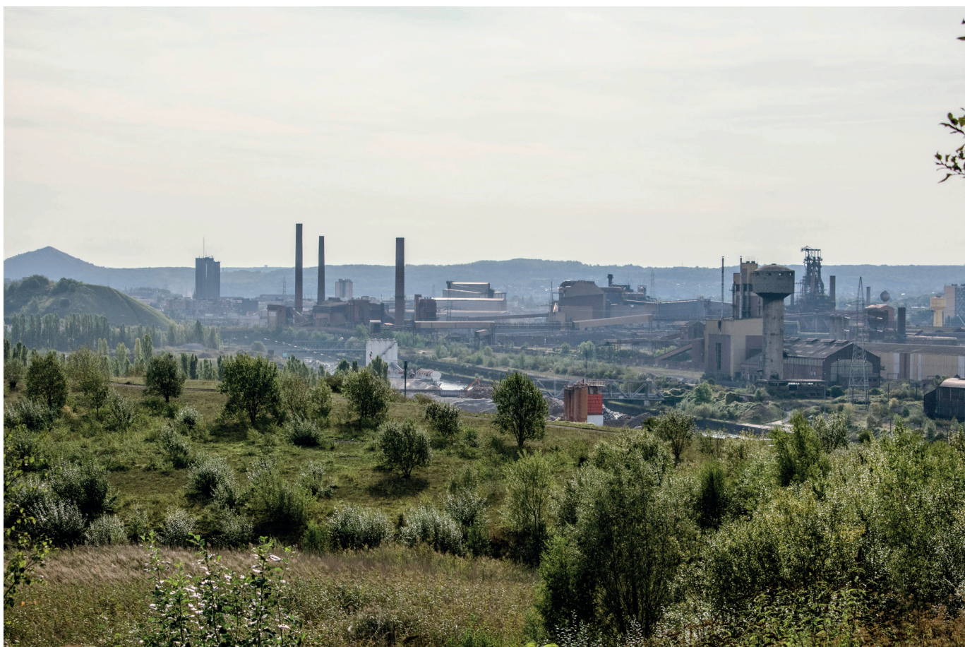
figure 19 : Porte Ouest de Charleroi : zone industrielle en grande partie désaffectée
