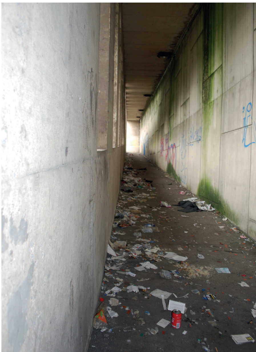
figure 84 : rampe du PBA
