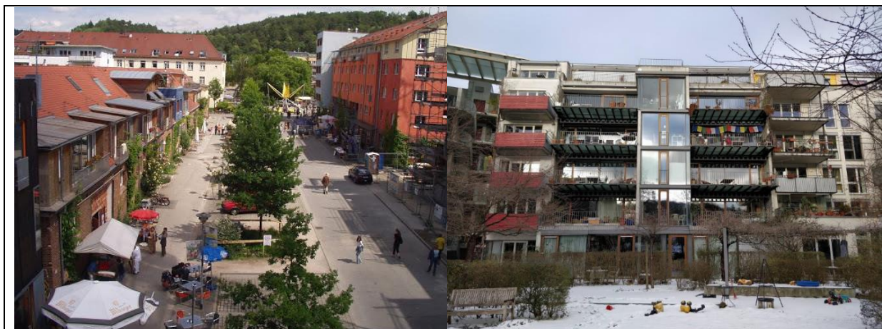
Figure 13 et Figure 14 : aménagements extérieurs à Tübingen
