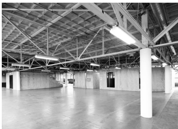
Figure 18 : Volumes préfabriqués disposés sur le plateau (Source : NL Architects)
