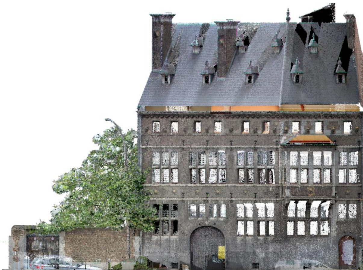
Figure 47 : Elévation avant depuis la rue de Fragnée
