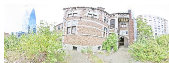
Figure 15 : Photo panoramique de la façade arrière de la maison Rigo depuis le jardin (Hallot P., 2017)
