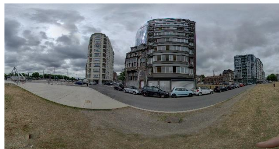
Figure 16 : Photo panoramique de la façade avant de la maison Rigo (Hallot P., 2017)
