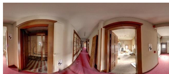
Figure 43 : Circulation 2 ème étage accessible par l'escalier de service (Hallot P., 2017)
