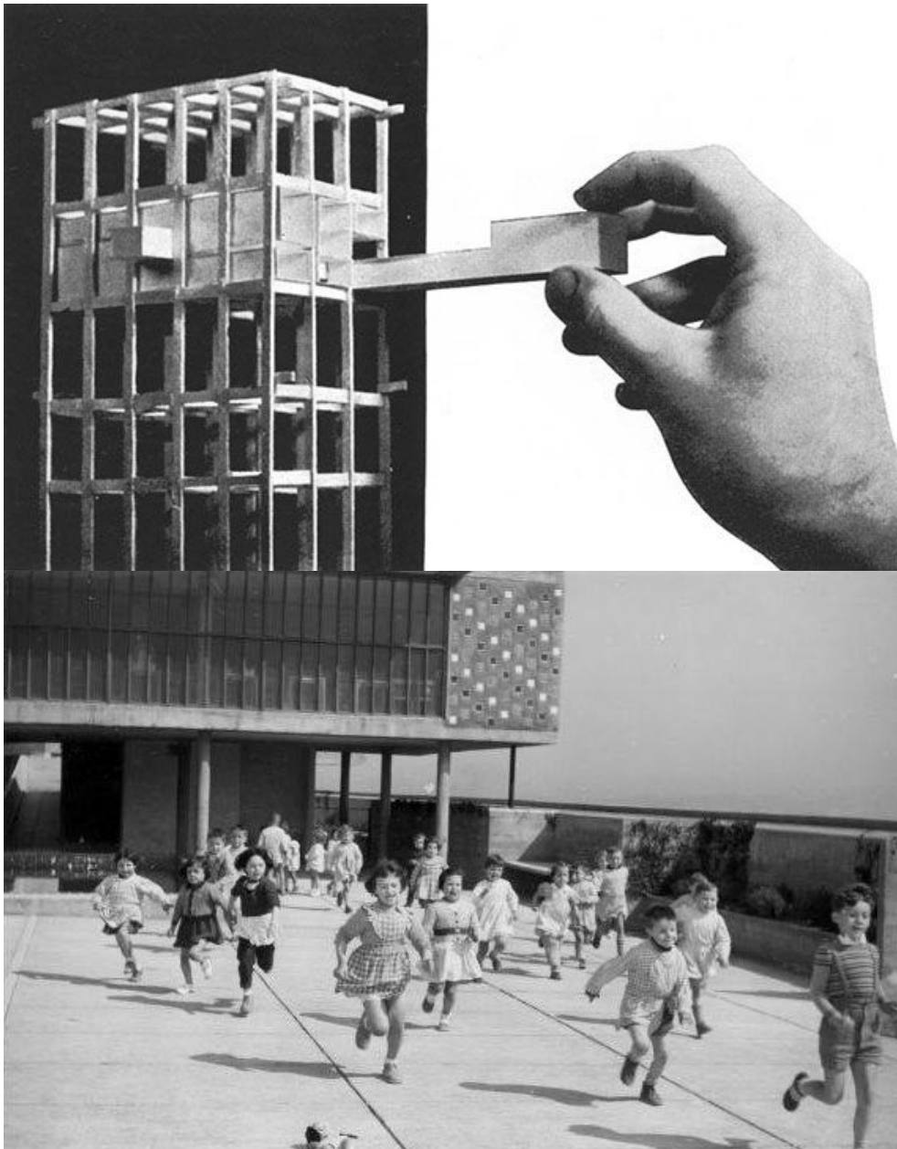
Figure 56 : LE CORBUSIER. Maquette de l'Unité d'habitation montrant l'insertion des cellules d'habitation dans une grille structurelle Figure 57 : LE CORBUSIER, Toiture de l'Unité d'habitation à Marseille (1947)
