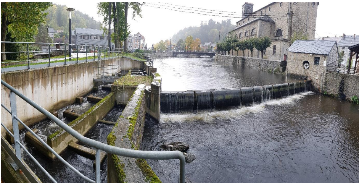
Figure 8: Vue aval du barrage du château de Nismes (Eau Noire) avec l'échelle à poisson (gauche).
