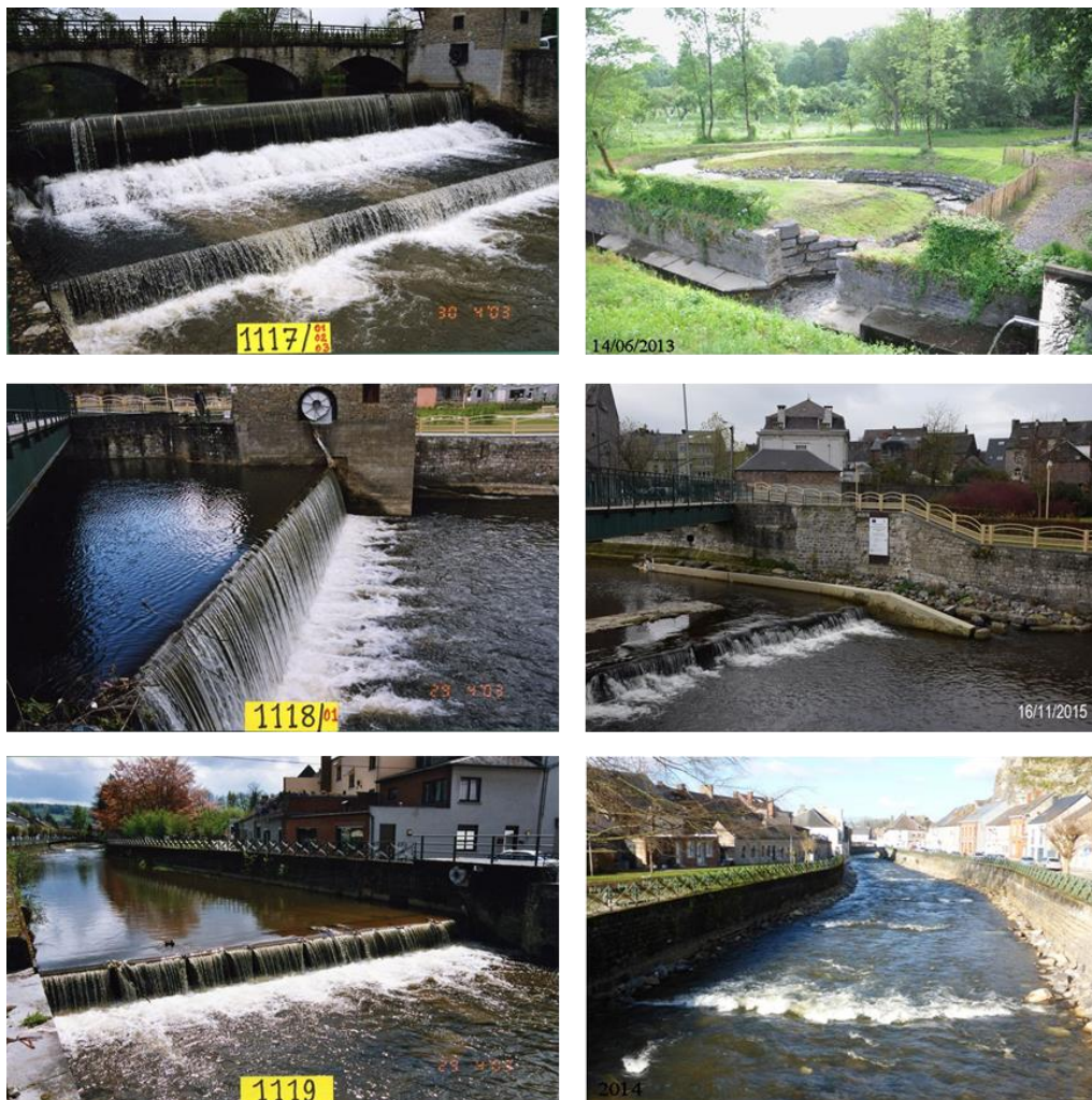
Figure 7: Obstacles (gauche) et leur aménagement (droite) sur l'Eau Noire, du haut en bas ; Barrage de Saint-Roch (1117), Rivière de contournement ; Barrage La Ruche Couvin (1118), Rampe rugueuse ; Barrage Rue de la Falaise Couvin (1119), Arasement /Effacement (source : SPW).
