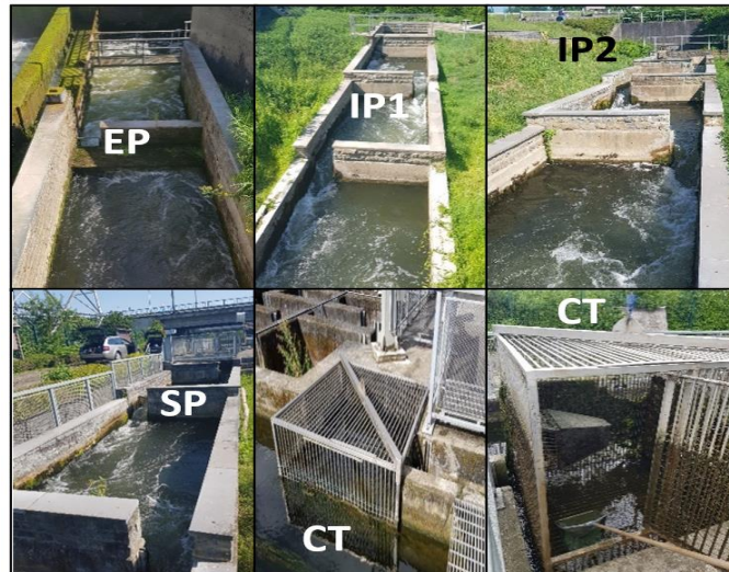
Figure 14: Les 4 Antennes RFID (EP=Entrée Passe; IP1= Intérieur Passe 1; IP2= Intérieur Passe 2; SP=Sortie Passe) et la cage de capture.
