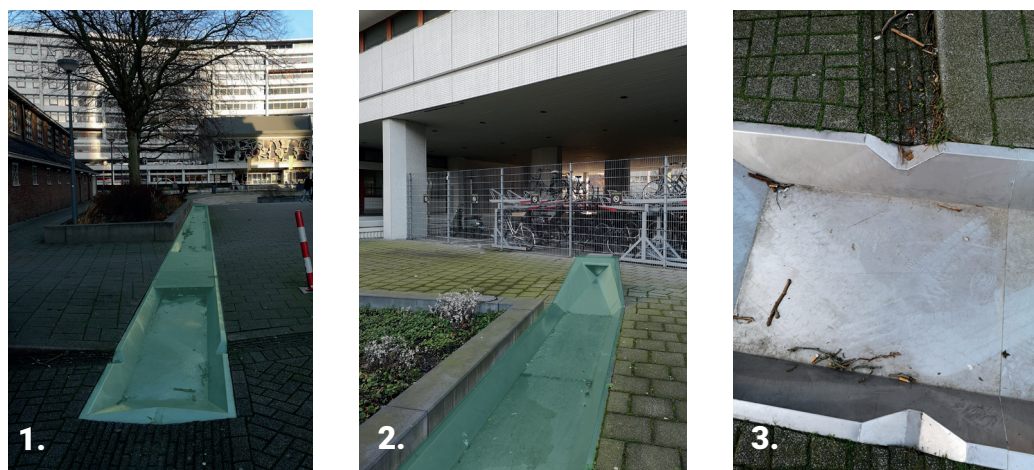
Figure 3.45. 1. Collecte des eaux de surface ; 2. Collecte des eaux de toitures ; 3. Gouttières inox
