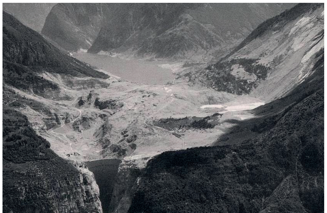
Figure 1.7. Vue aérienne du barrage du Vajont le lendemain de la catastrophe, montrant le glissement de terrain occupant l'emplacement de la partie aval du lac de retenue, contre le barrage dans le bas de la photo
