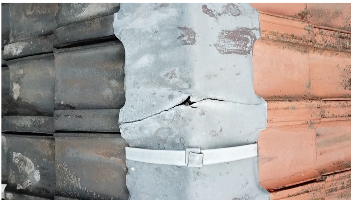
Fig. 7. Fissure dans le plomb du faite du bâtiment haut.
