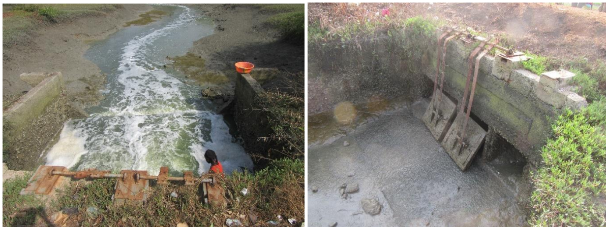
Figure 4 – Ouvrage régulateur et vanne à clapet.
