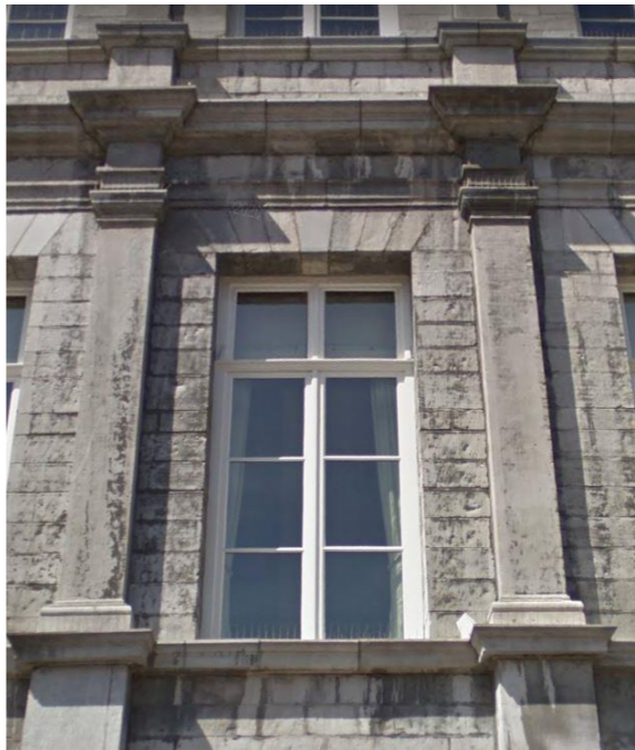
102. Linteaux et appareillage de l’Hôtel de ville de Maastricht (1659-1684) 102 :
