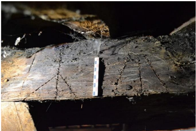
78. Assemblage des pannes inférieures 78 :
