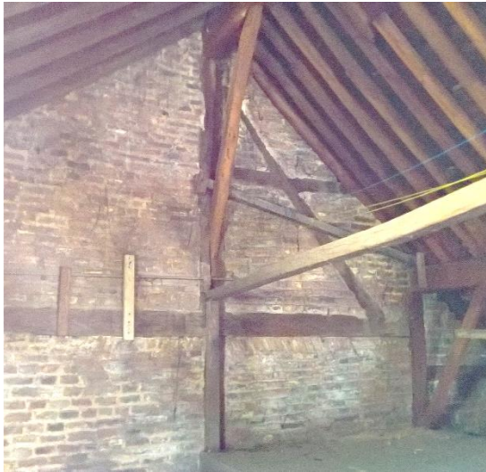
64 : Vue de la partie haute du pan-de-bois mitoyen 64 :
