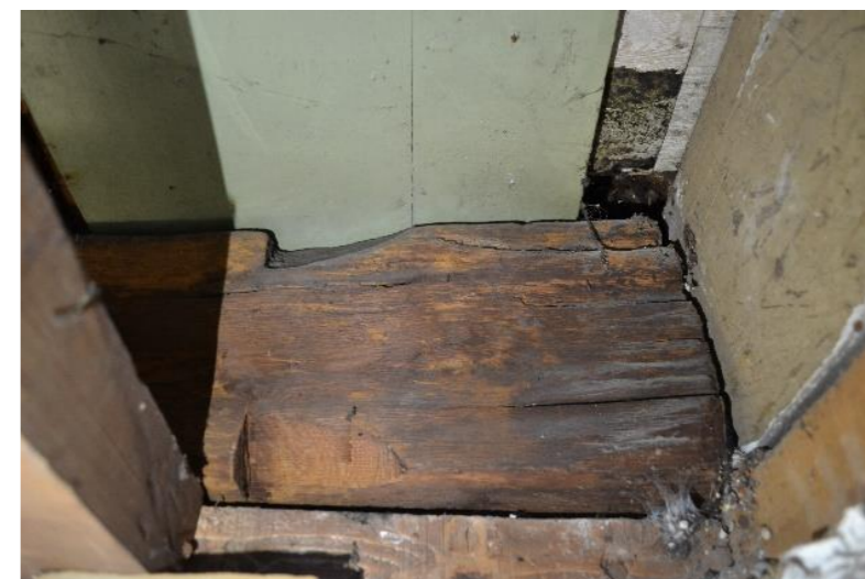
62. Trace de levage sur une poutre 62 :
