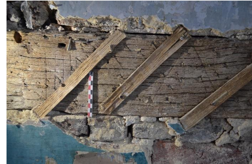
66. Marques d'assemblage sur une entretoise du 2 e étage 66 :
