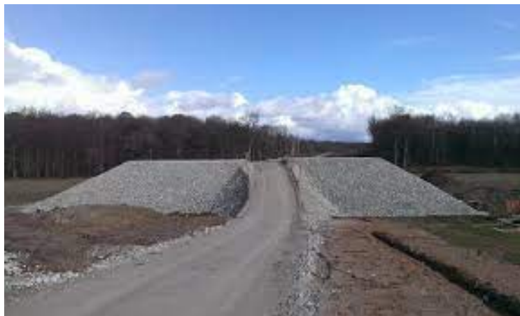
FIGURE 13 – Préchargement à l'aide d'un remblai
