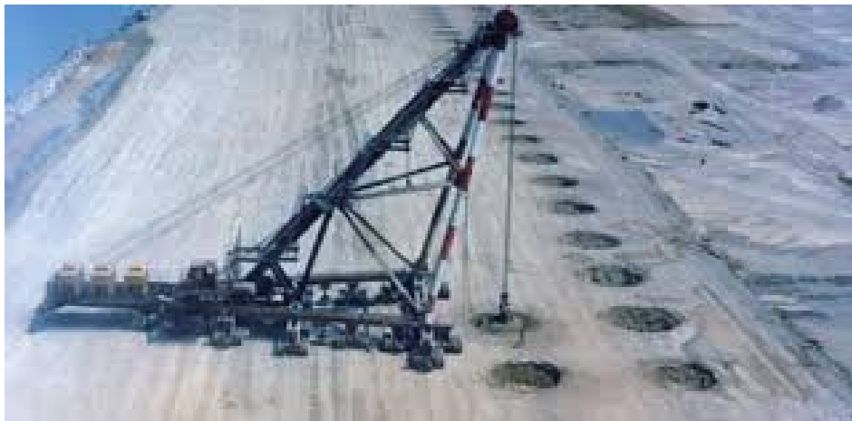
FIGURE 2 – Compaction dynamique de haute énergie (4000Tm) pendant les travaux d'extension de l'aéroport de Nice [Varaksin, Chu, Klotz, Mengé,2009]
