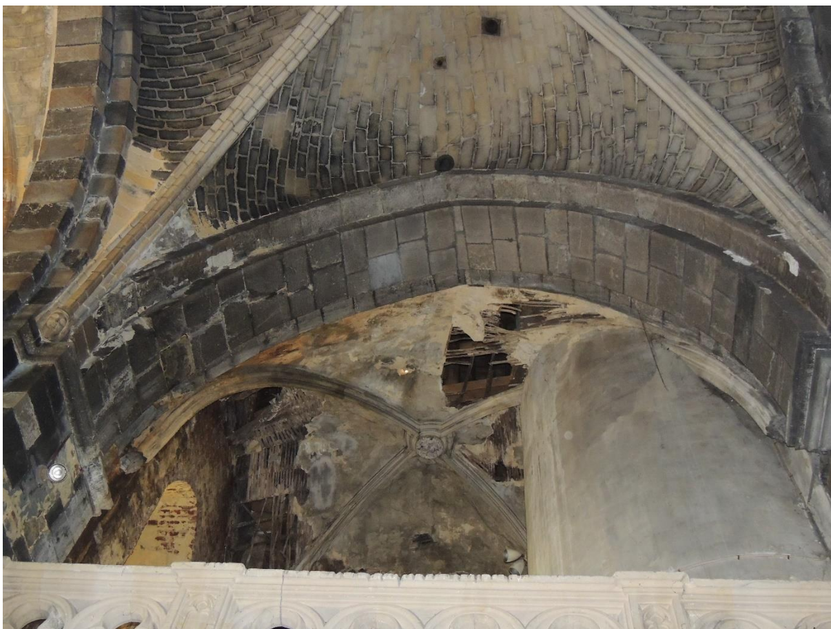
Fig.36 : Voûte dont on peut maintenant observer aisément la matérialité de plâtre et de lattes que lui a substitué Delsaux.
