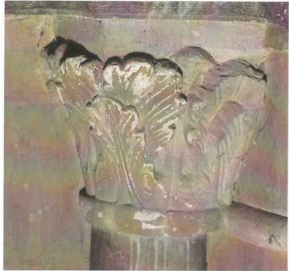
Fig.31 : Traces visibles des réparations au plâtre de Delsaux sur le chapiteau d'un abside.
