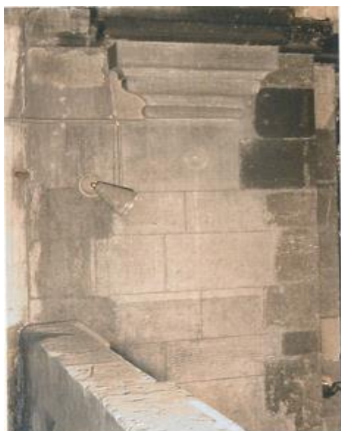
Fig.42 : Pilier dont la peinture imite les techniques de taille posée sur un enduit.
