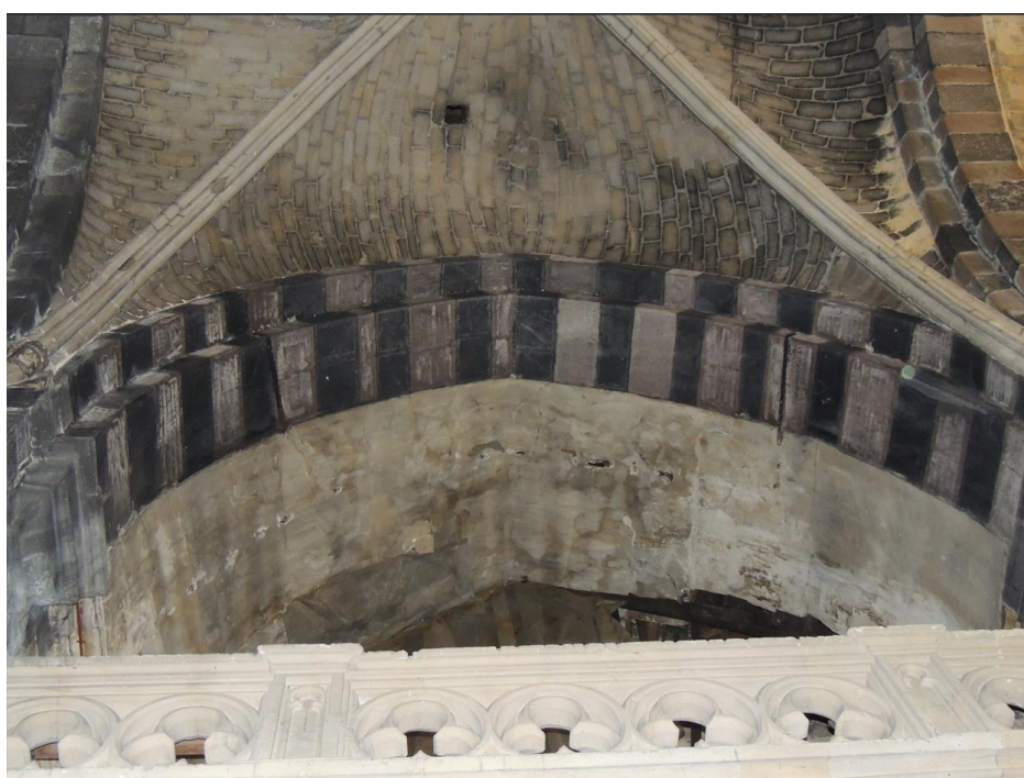
Fig.41 : Arcade couverte de la peinture bichrome imitant l'alternance de claveaux en
