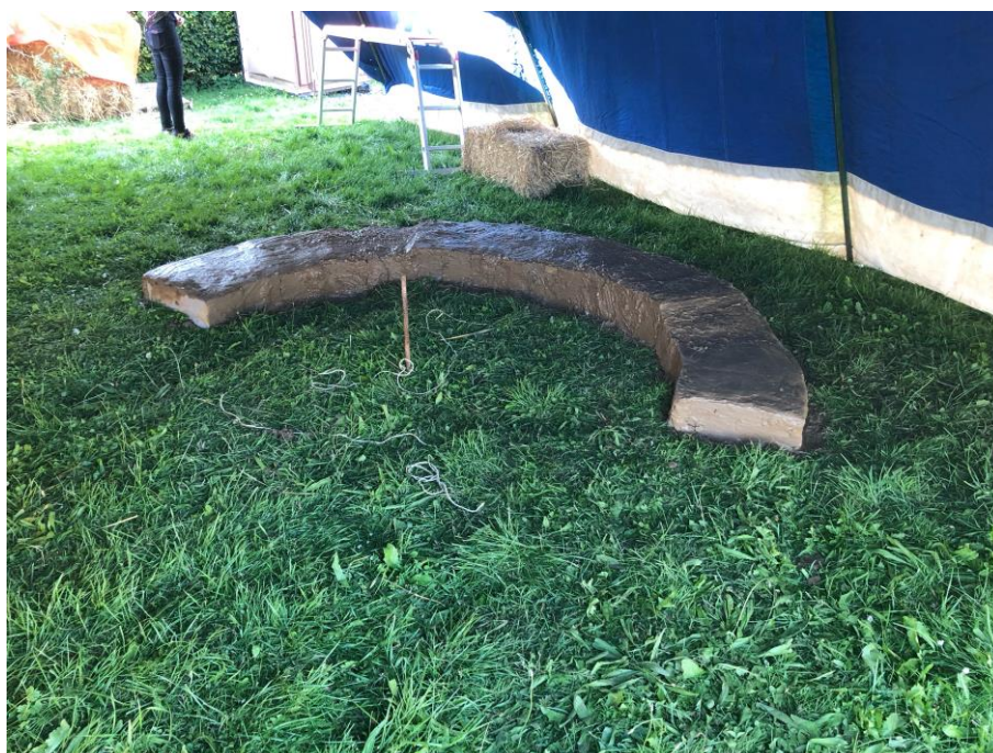
Figure 86 – Construction des fondations de la cabane
