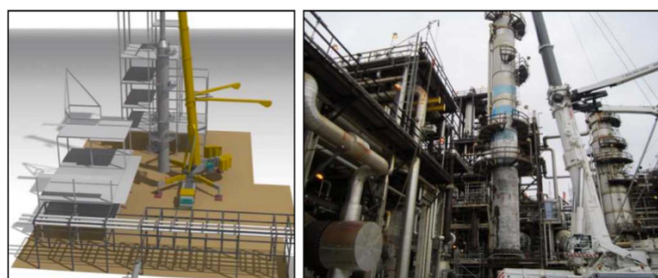
Figure 41 - Opération de levage (modèle 3D vs réalité)
