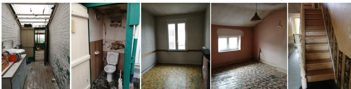
Figure 7-2 : De gauche à droite – espace de cuisine vétuste dans la véranda, w.c. extérieurs vétustes, chambre à transformer en salle de bain, chambre avec éclairage naturel insuffisant, escalier à conserver et éventuellement rafraichir.
