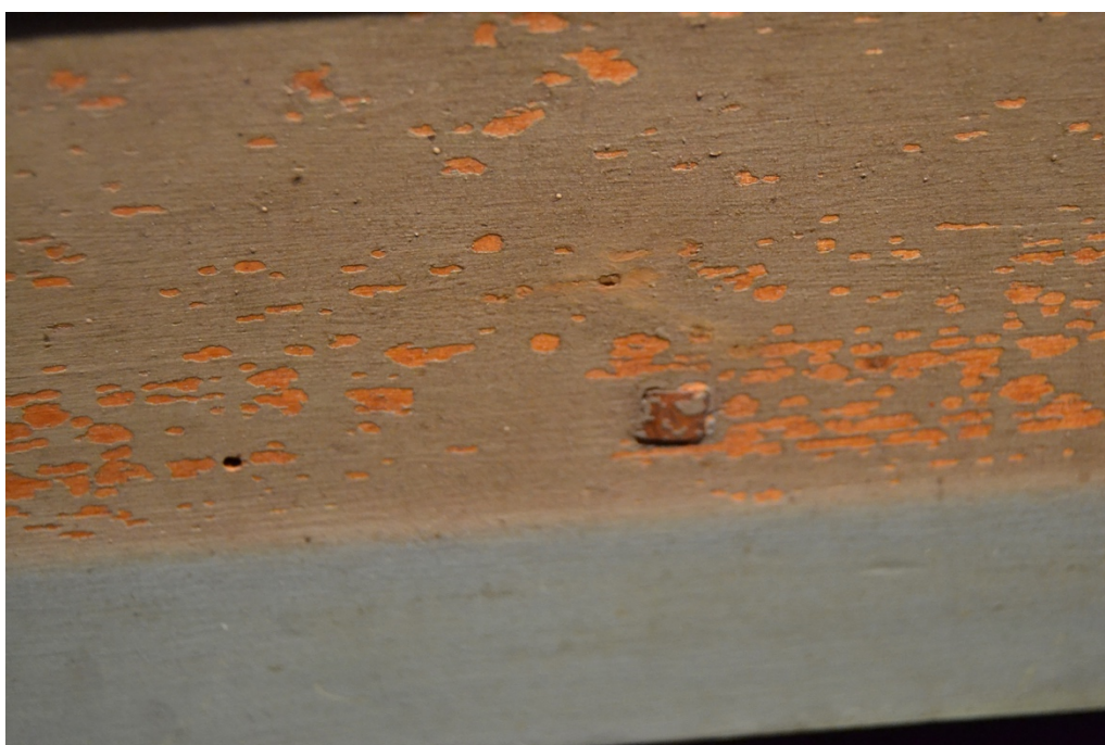
Figure 67: Détail de gorge. On voit une cheville carrée qui vient consolider le joint entre la gorge et le sommier. On peut également remarquer la différence flagrante entre la peinture oxydée et la peinture protégée par le couteau.
