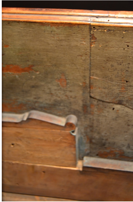
Figure 46: L'assemblage à mi-bois vu de l'intérieur de la joue.
