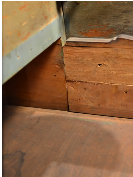
Figure 47: Moulures qui prolongent les moulures des châssis. On peut voir que Bull a réalisé ces moulures en plusieurs pièces.
