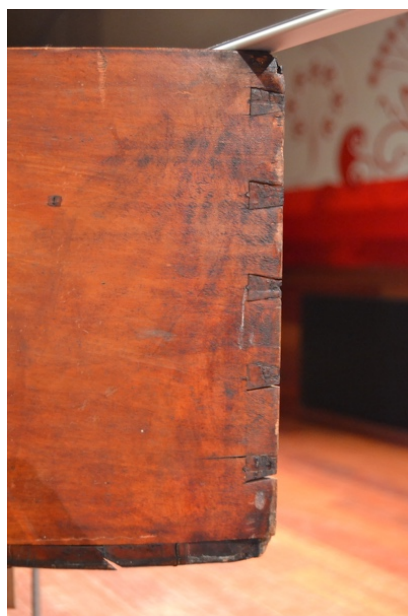
Figure 34: Queues d'arondes au joint reliant l'éclisse courbe et l'échine. On peut y voir une symétrie avec la photo précédente.
