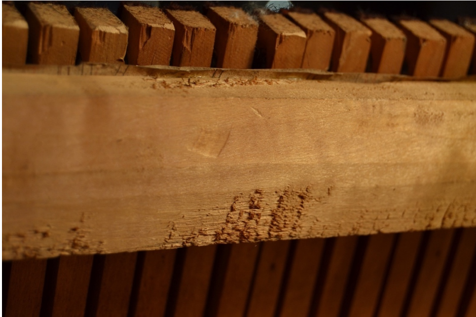
Figure 107: Traverse arrière du clavier supérieur. La qualité des finitions sur le châssis supérieur est médiocre. Le châssis a pu être retravaillé après la mort de J.P. Bull mais cela semble peu probable. Ce manque de soin sur certaines parties du clavier a mené à penser que le clavier a pu être construit par une autre personne que J.P. Bull. Nous avons par après démontré que cette théorie était peu probable.
