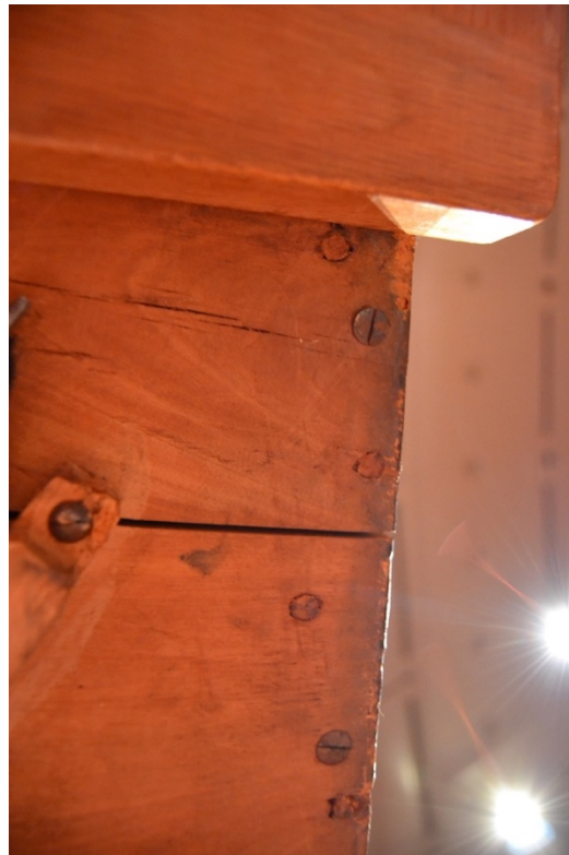
Figure 40: Genouillère. On y voit le pivot et les vises qui tiennent le bloc de genouillère.
