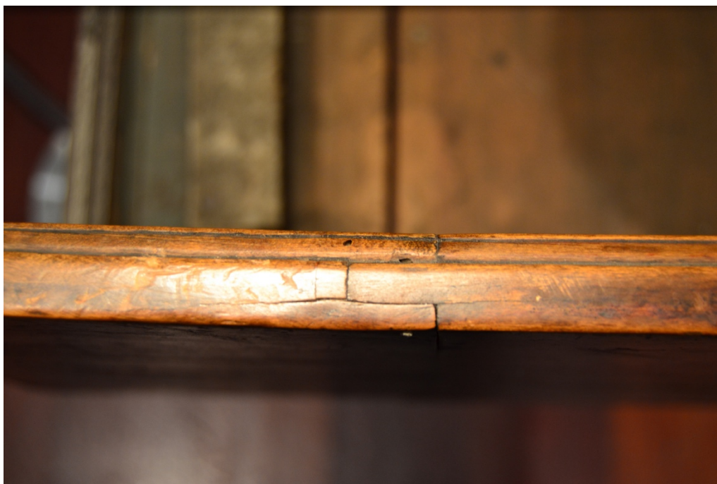
Figure 44: Chant de la joue. On peut voir l'assemblage à mi-bois.
