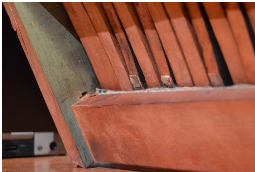
Figure 106: Vue du dessous châssis du clavier inférieur. La traverse arrière n'est pas au même niveau que les bras du châssis.
