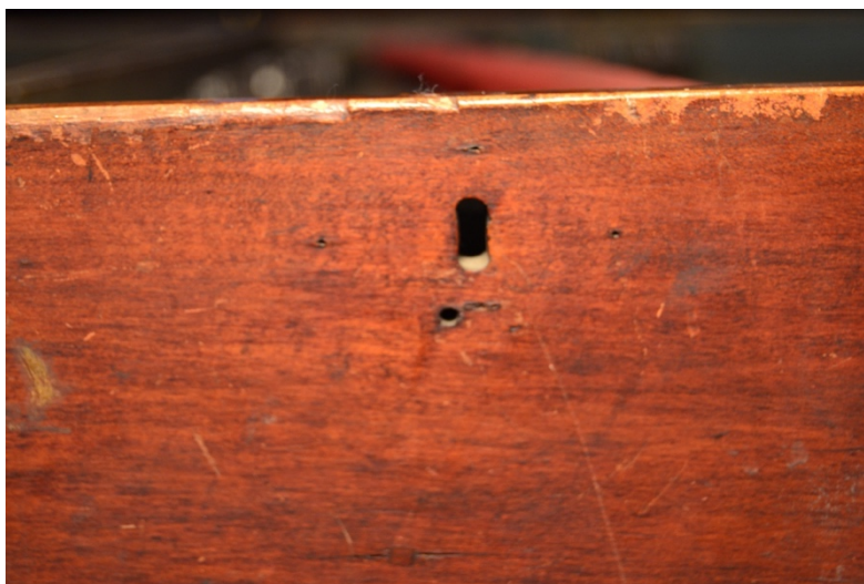
Figure 42: Trou de la serrure sur la joue. On voit quatre trous de clous qui devaient tenir la ferrure.
