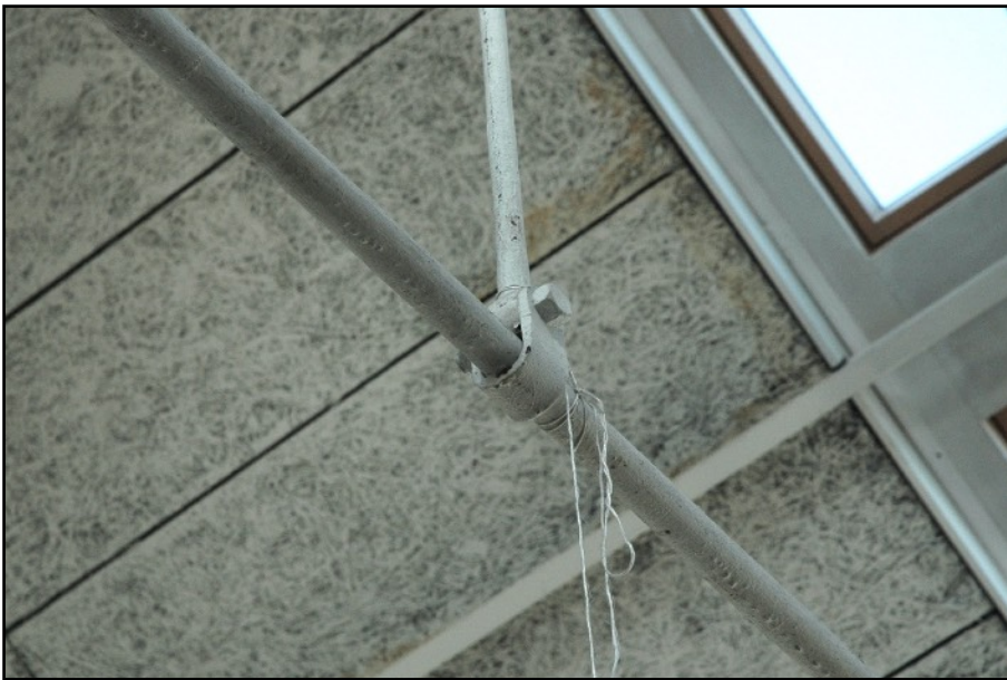
Fig. 79 : Assemblage du poinçon et de l'entrait d'une des fermes du grand laboratoire, photographie personnelle, 06/10/2021.
