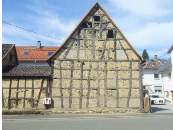
Figure 1 : Maison à colombage produite avec du torchis (source : Build-green.fr)
