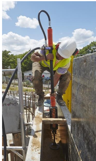
Figure 48: Réalisation de murs en terre damée avec un compactage pneumatique (source : architectureterrebois.fr)
