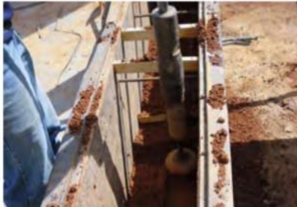
Figure 16 : compactage pneumatique d'un mur en pisé (source : Birznieks, 2013)
