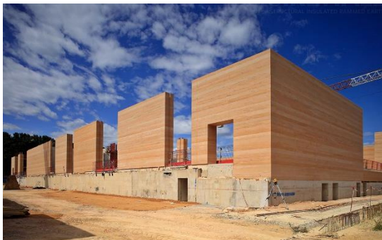
Figure 4 : Réalisation en terre damée stabilisée (source : narbovia.fr)
