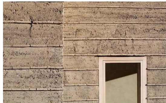
Figure 5 : Réalisation en béton damé (source : actu.epfl.ch)
