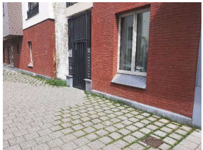
Figure 34 : Pavés à joints larges et végétations en pied de façade (document personnel)
