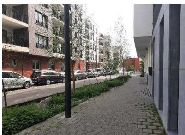
Figure 27 : Noues en voirie et pavés à joints larges (document personnel)
