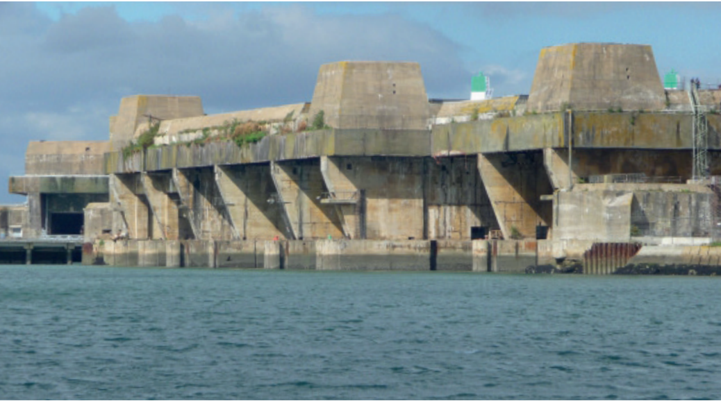
Toiture à bloc de la base de Lorient. Source : https://journals.openedition.org/insitu/312
