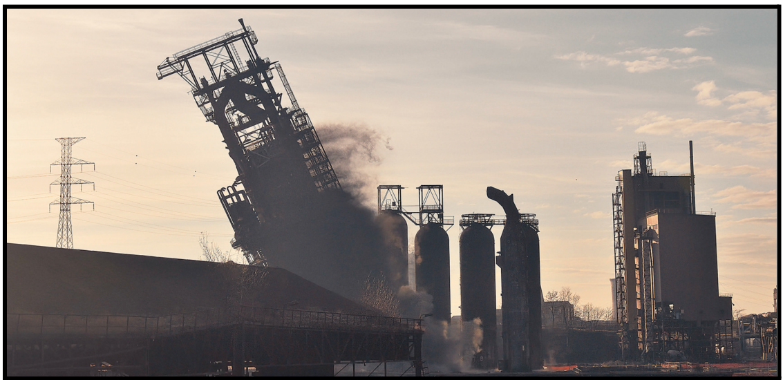
Figure II.2.1 : Dynamitage du haut-fourneau HF6 (Source : Gaudry Steph)
