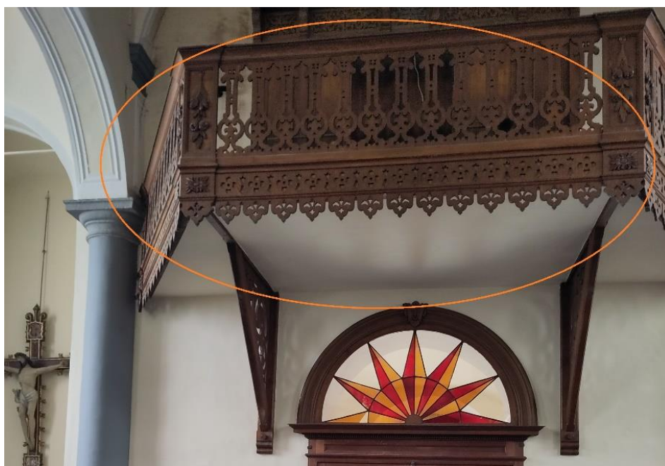
Figure 23 : Porte-à-faux du Balcon servant à l'organiste
