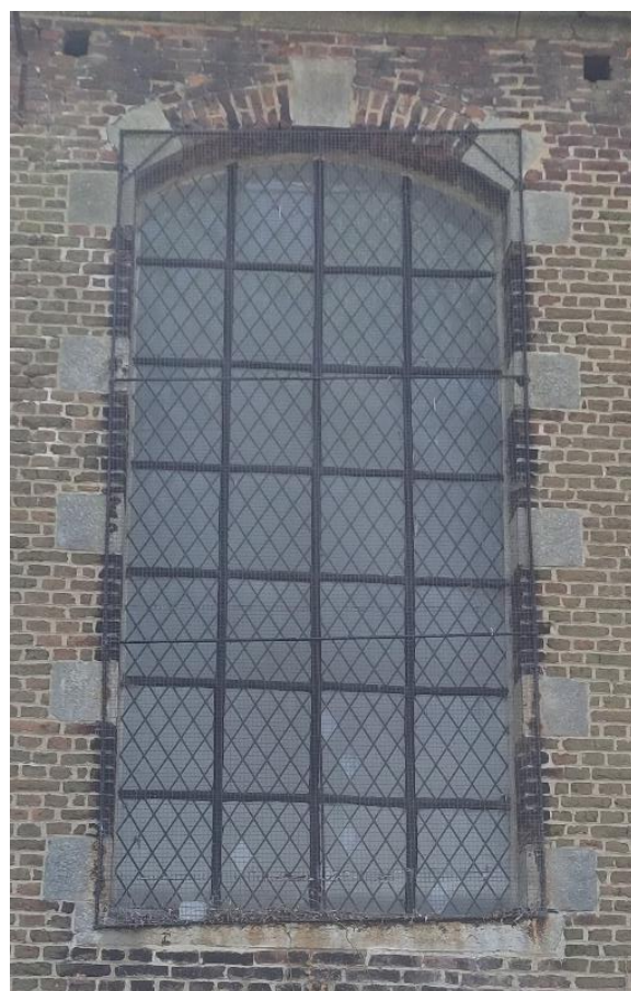
Figure 13 : Traces de rouille sur les vitraux des bas-côtés
