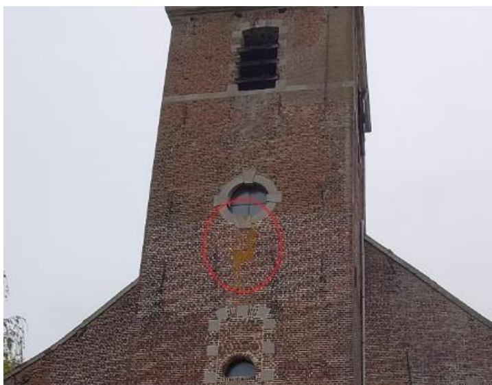
Figure 12 : Dégradation sous l'œil de bœuf du clocher
