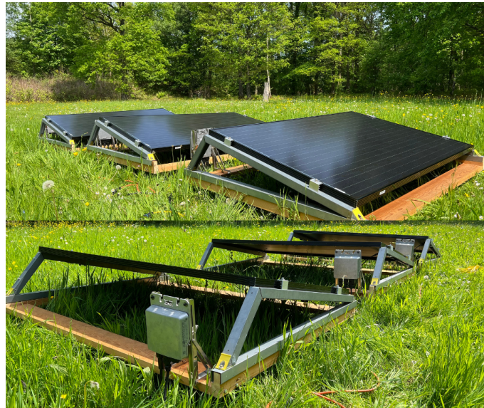
FIGURE 4.7 – Supports, micro-onduleurs et Panneaux solaires
