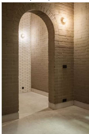
Figure 24 : Murs construits en BTC © BC materials
