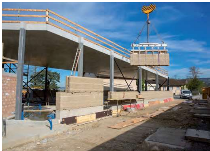
Figure 43 : Pose des éléments préfabriqués (Gauzin-Müller, 2018)
