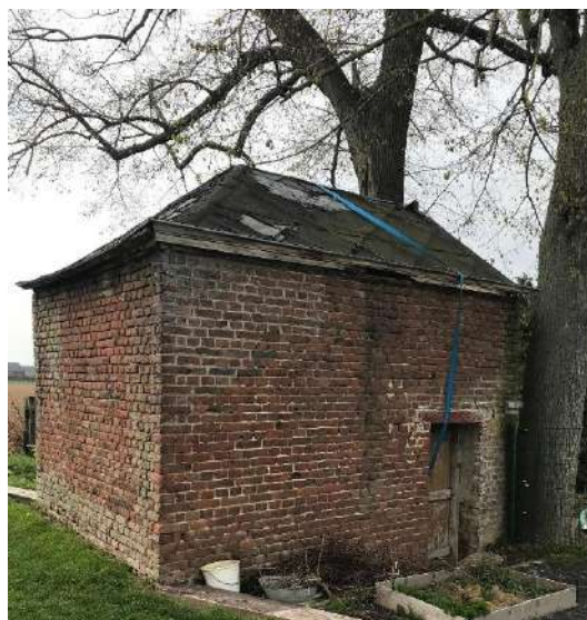
Figure 50: état de l'édifice après une tempête en 2022. Façade arrière et gauche. On observe la porte en bois à linteau droit sur la façade gauche. On distingue également le matériau de toiture. Sarah Aniciato, 2022.
