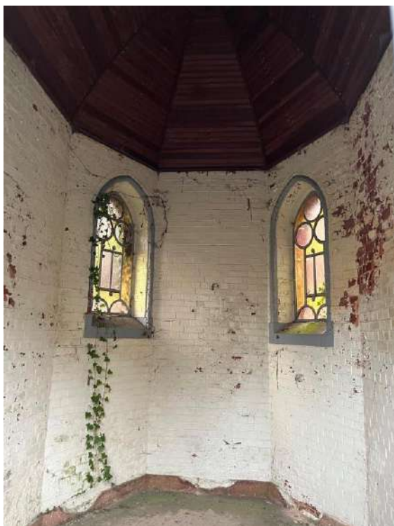
Figure 140 intérieur de la chapelle, qui montre le chevet à plusieurs pans et la toiture à cinq versants même si l'arrière de l'édifice est inaccessible. Louise Schröder, 21 décembre 2022.
