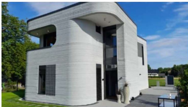
FIGURE 2.6 – La maison imprimée à Beckum [F.P. BOS et al. 2022]
