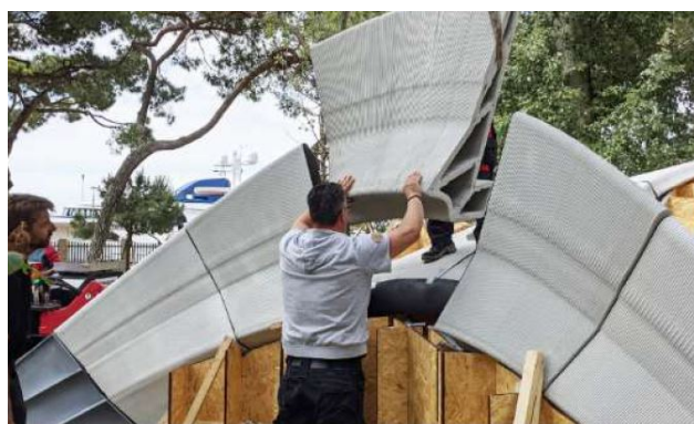
FIGURE 2.9 – Assemblage sur site de la passerelle The Striatum [F.P. BOS et al. 2022]
