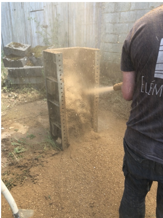
Figure 3.25 : Projection avec beaucoup de rebond
