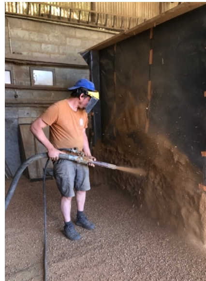
Figure 3.33 : Pied du mur encombré par le rebond
