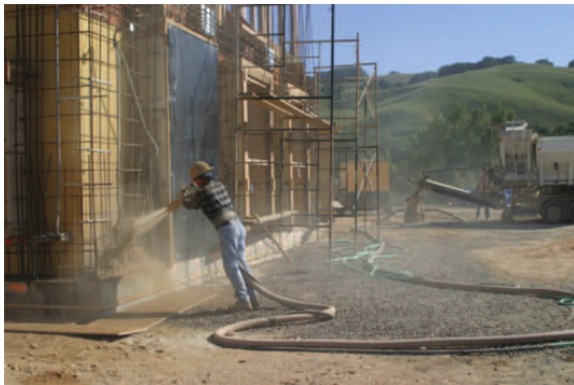
Figure 2.24 : Projection de terre
