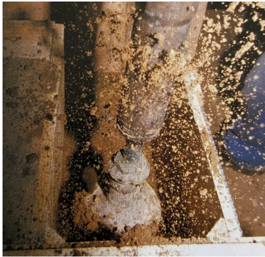
Figure 2.13 : Fouloir pneumatique en action
