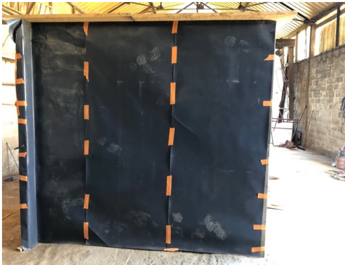
Figure 3.32 : Coffrage avec carton de désolidarisation
