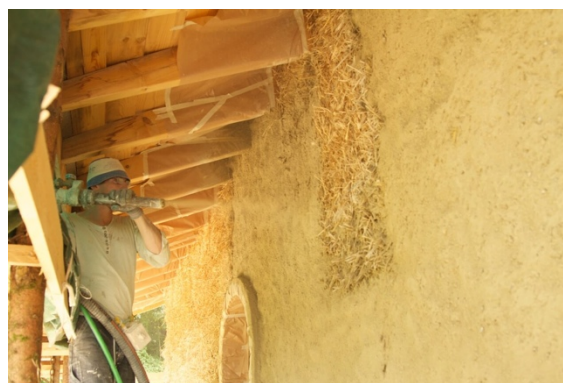
Figure 2.27 : Projection sur mur en paille pour finition
