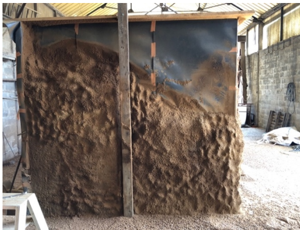
Figure 3.34 : Avancement de projection
