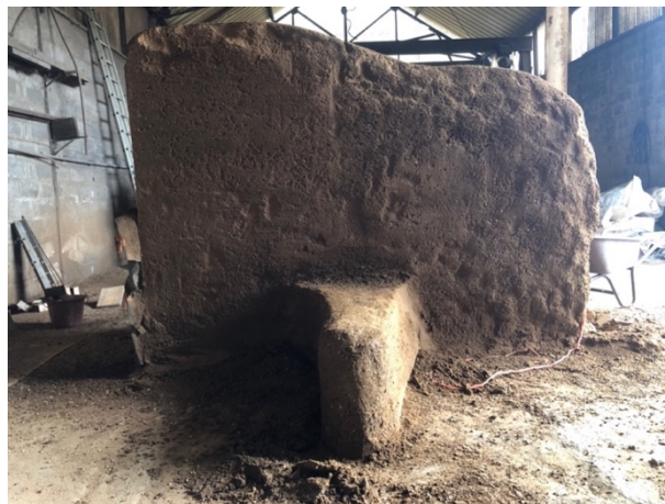
Figure 3.35 : Voile et banc terminés
