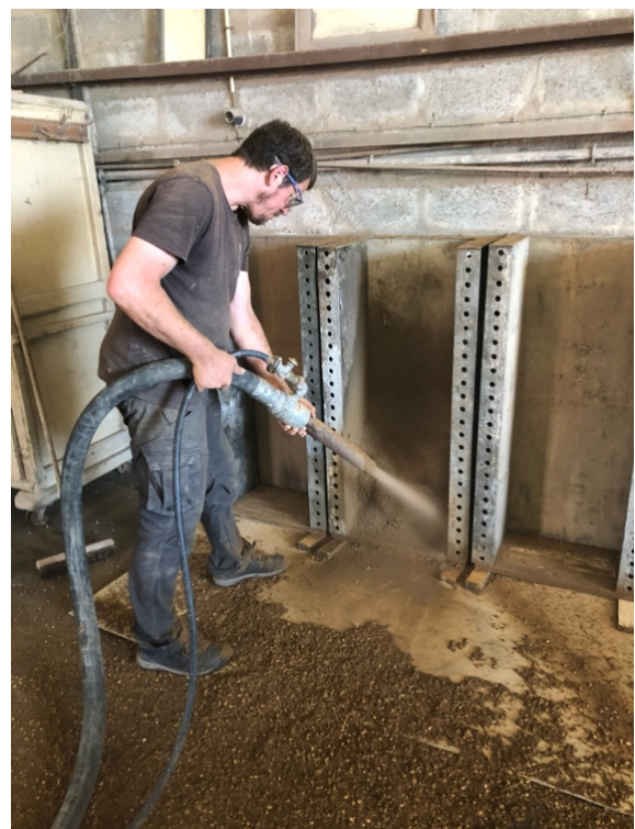
Figure 3.26 : Projection avec rebond contrôlé
