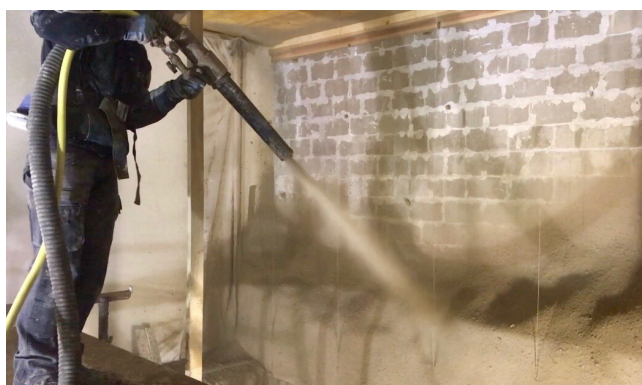
Figure 2.26 : Projection contre mur pour un bouteiller
