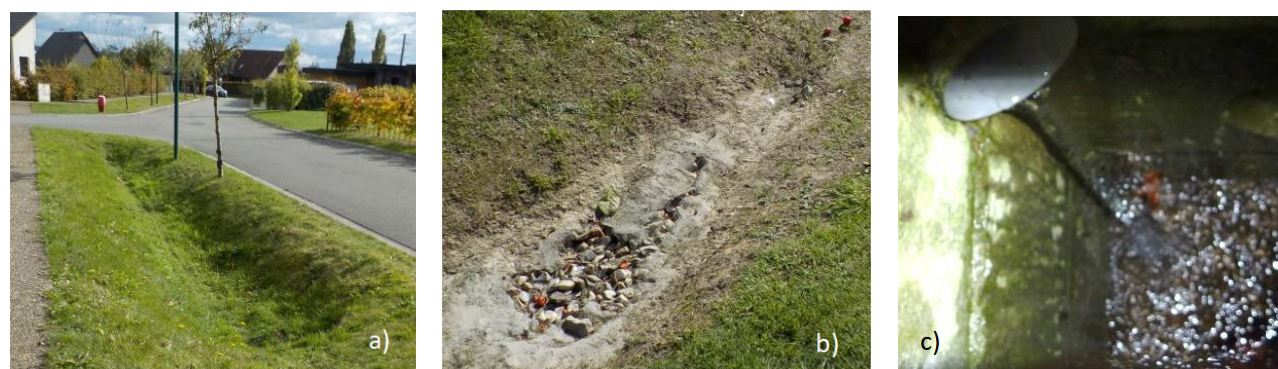
FIGURE 1.3 – a) Noue drainée – b) Massif drainant affleurant sous géotextile déchiré – c) Rejet des eaux issues des massifs drainants dans un regard en aval (Ledun et al. , 2018).
