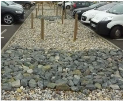
FIGURE 1.6 – Tranchées drainantes (Ledun et al. , 2018).
