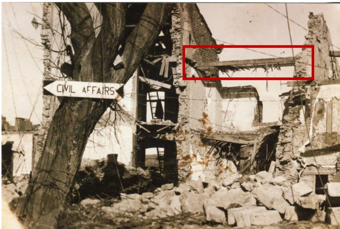
Figure 62 : Bâtiment en ruines avec des solives paraissant intactes, Bastogne, Bataille des Ardennes, 1944-1945. © Coll. Bastogne War Museum
