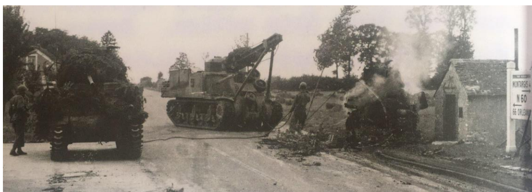
Figure 36 : Les troupes du Génie américain utilisent un char de dépannage sur châssis M3 pour débayer la route en enlevant une épave d'un autre char, Montargis, France, août 1944. © NARA
