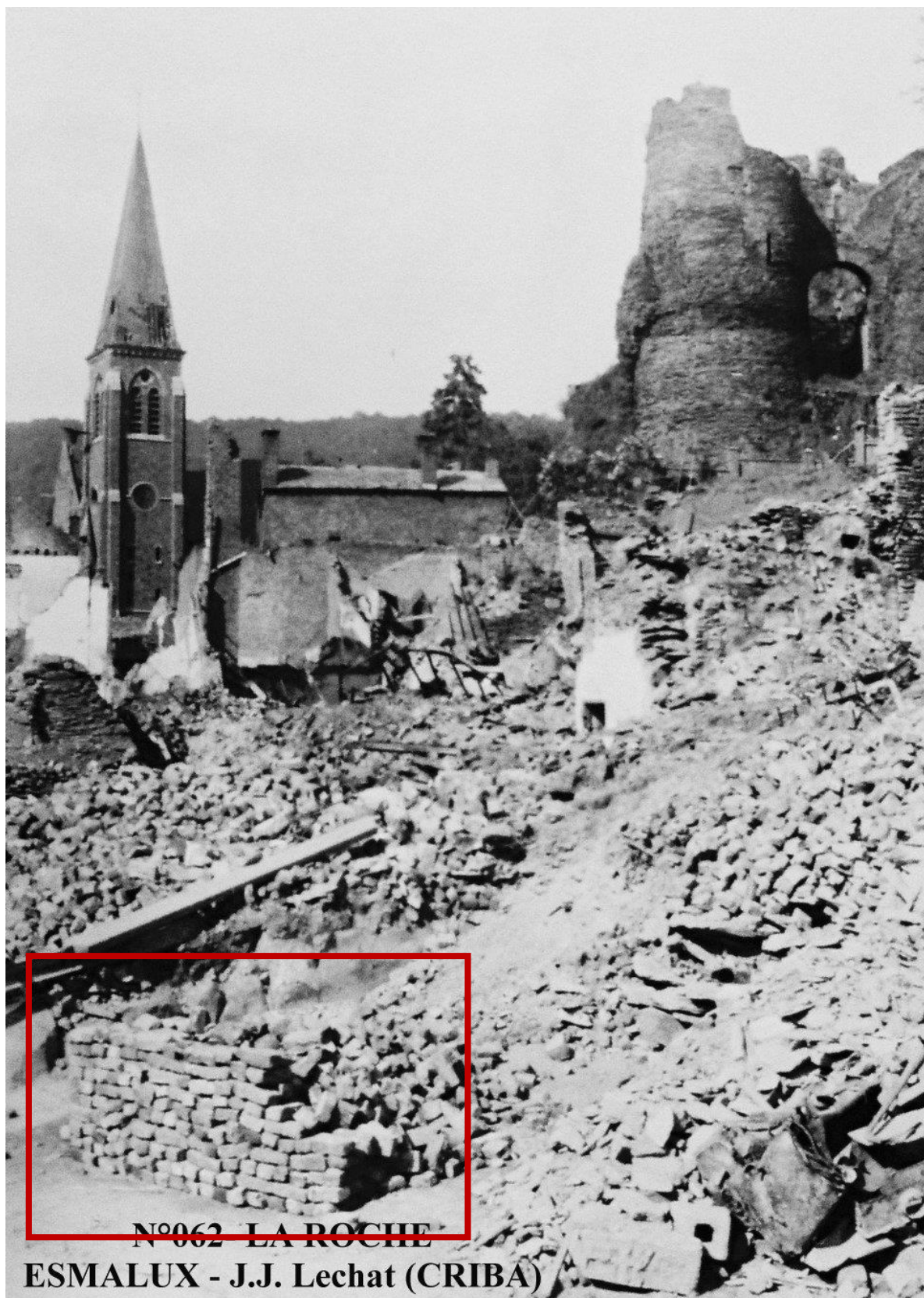
Figure 61 : Briques tirées hors des ruines et triées de manière apparente pour être réutilisées, La Roche, Bataille des Ardennes, 1944-1945. © Coll. Bastogne War Museum
