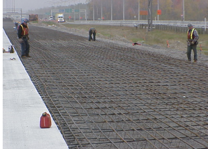
FIGURE 2.2 – Pose des aciers transversaux et longitudinaux dans le cas d'une chaussée en béton armé continu [THÉBEAU 2004]
