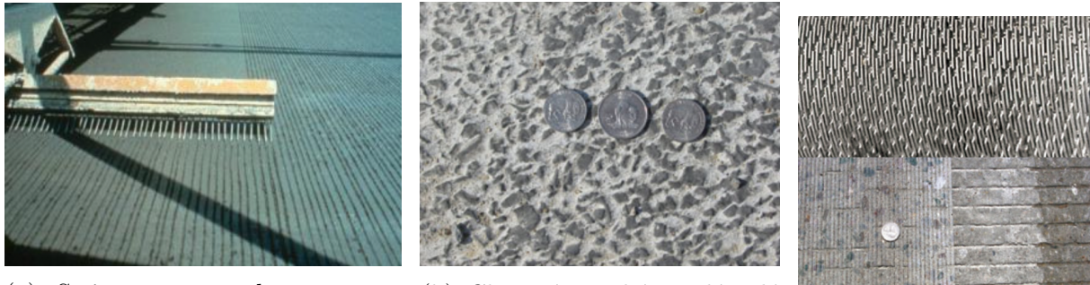
(a) Stries transversales avec un peigne métallique (b) Chaussée en béton dénudé (granulats exposés) (c) Meulage au diamant
