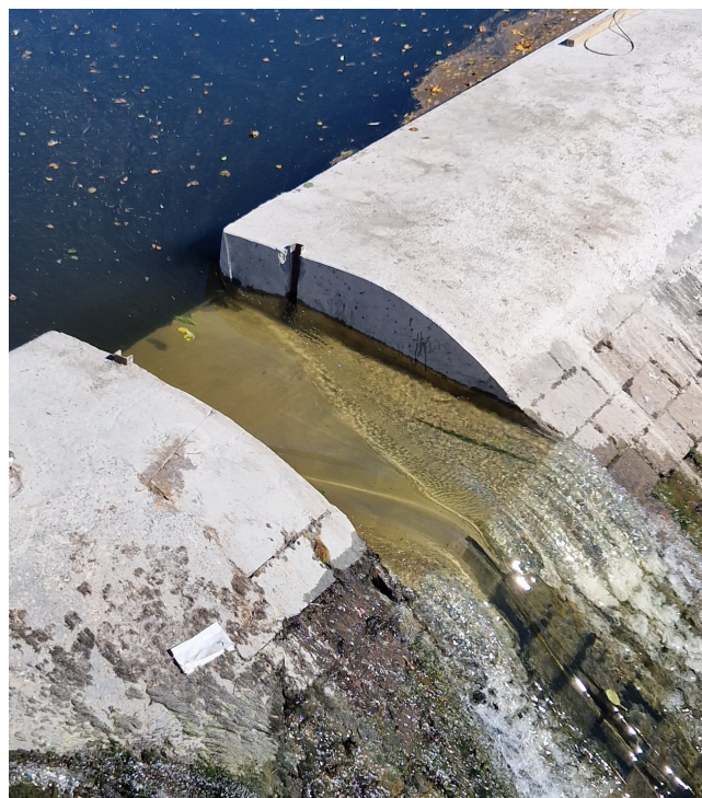
Figure 4.16: Incision sur le déversoir des Grosses-Battes
