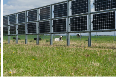
(e) Centrale à modules bifaciaux (Crédit photo : Next2Sun)
