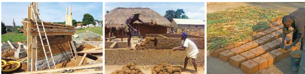
Figure 2-12 : Techniques de mise en œuvre de la terre crue : 1-le pisé, 2-la bauge, 3-l'adobe (Dejeant et al., 2021)
