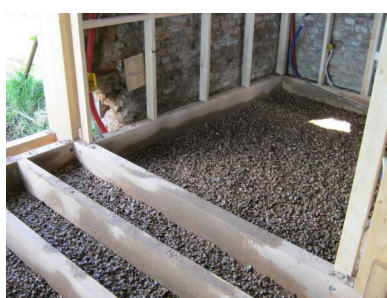
Figure 101 : Exemple d'isolation en coquillage -Infogreen
