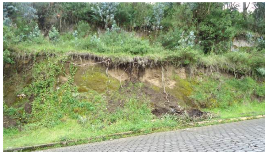
Illustration 60 – Glissement d'un talus
