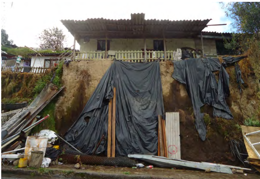
Illustration 86– Exemple de coupe verticale dans les talus
