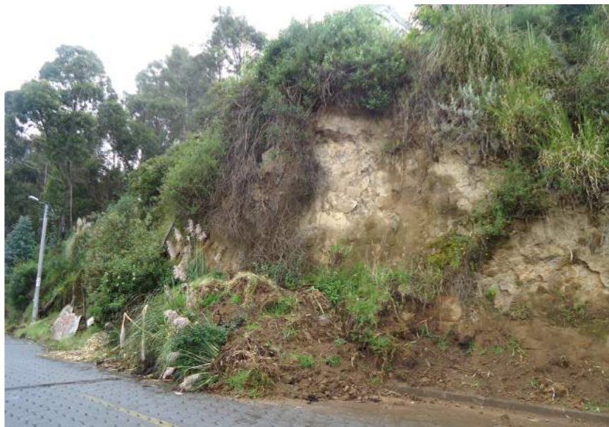
Illustration 59 – Glissement d'un talus sur la route
