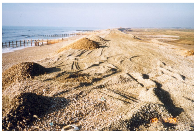
Figure II.9. Réapprovisionnement de la plage, 1998. Source: SCOPAC
