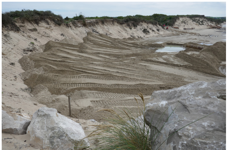
Figure I.16. Apport de sable sur une plage de Wissant. Source: Amis de la baie de Wissant.
