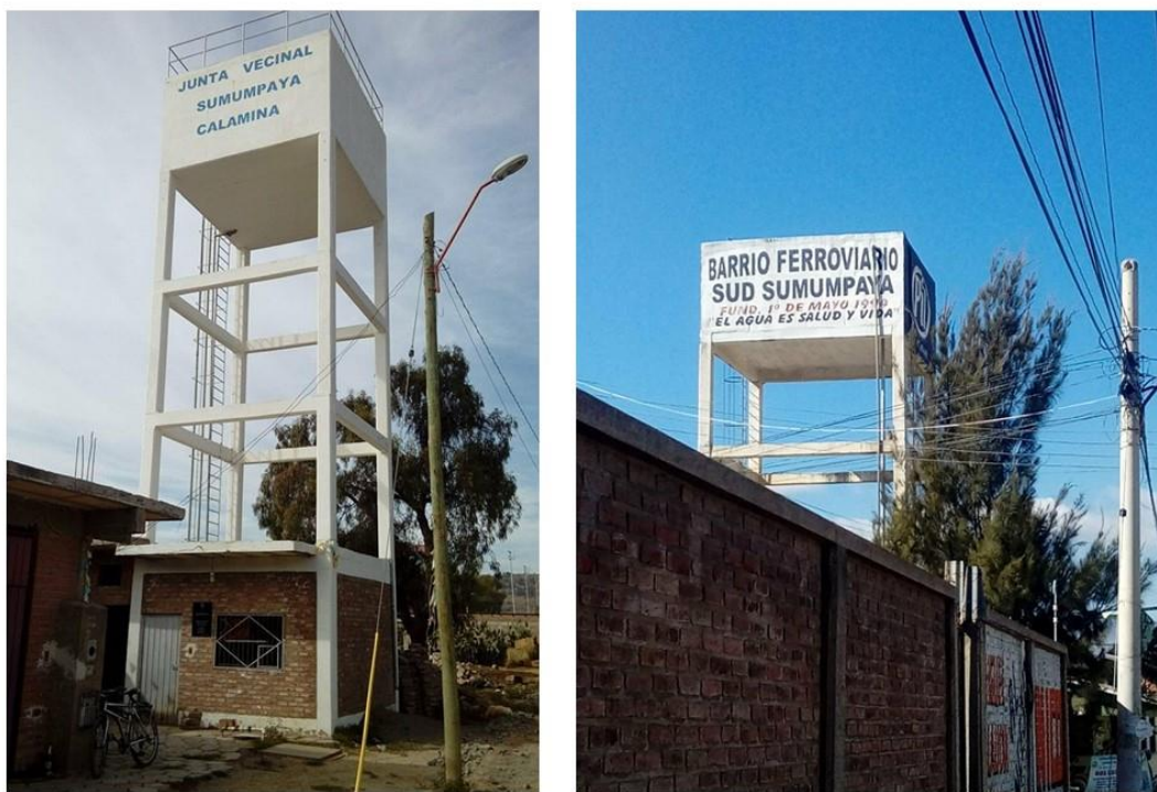
Figure 46 - Deux réservoirs hauts dans lesquels est pompée l'eau des puits électriquement pour ensuite être distribuée dans le réseau, quartiers CALAMINA et SUMUMPAYA FERROV. SUR. - SOURCE : Photos personnelles
