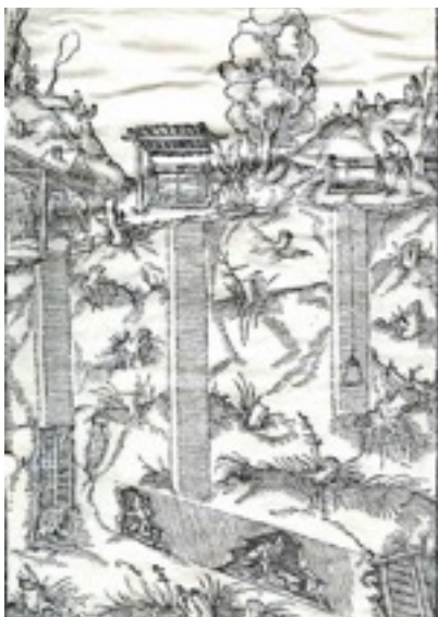
Puit d'extraction à différents stades d'avancement, milieu du XVIème Siècle, Georgius Agricola « De Re Metallica »
