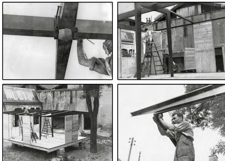
Figure 10 : Montage du prototype aux Ateliers Jean Prouvé à Nancy, 1944 (Coley, 2016)
